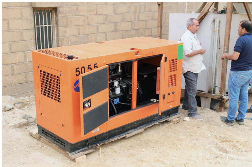
図版1 新たに増設したジェネレーター
